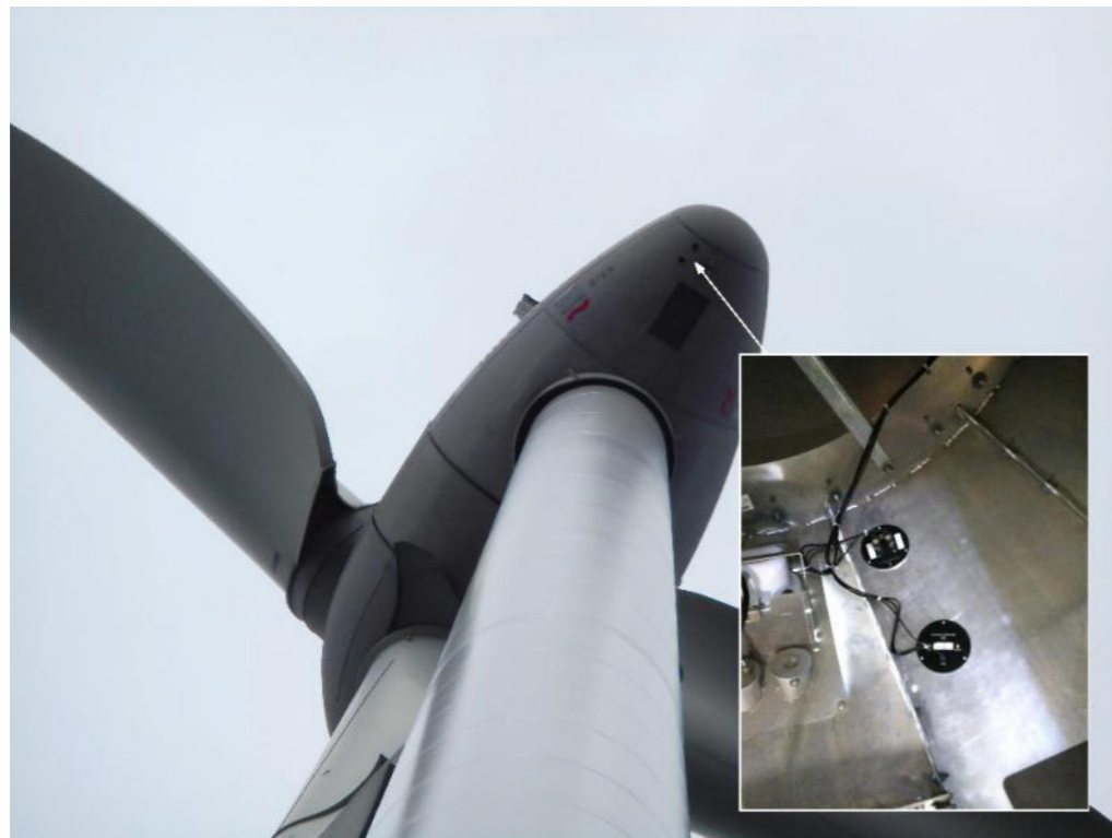
Photographie 1 : Dispositif installé sur la nacelle de l'éolienne
